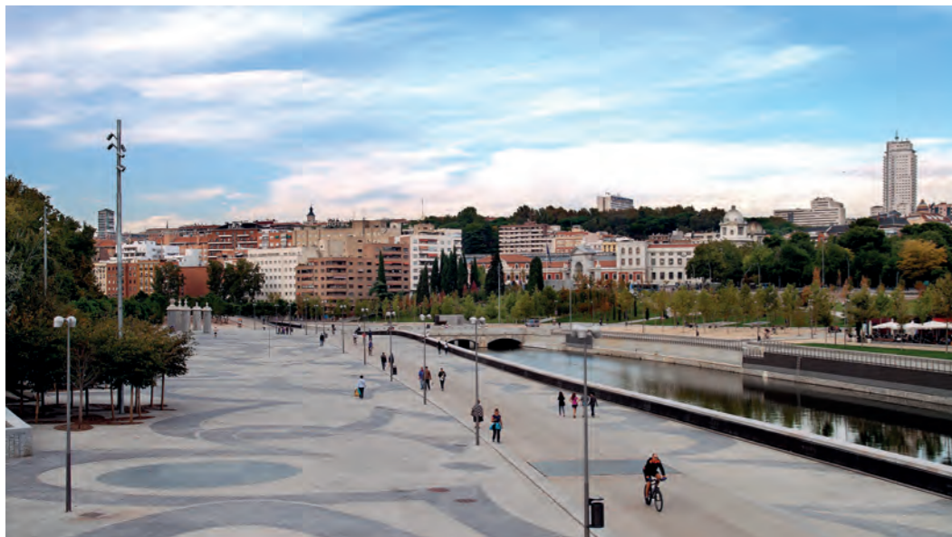
En la zona del Puente del Rey se rediseñó el tratamiento del solado © Ana Müller
